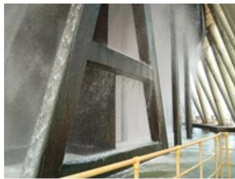
图 4 冷却塔结冰
