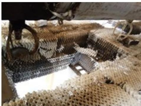
图 3 淋水填料堵塞垮塌情况
