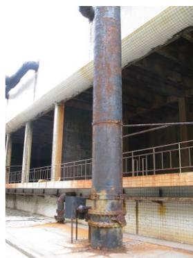
图 2 海水冷却塔上塔管腐蚀情况
