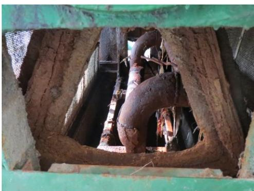
图 1 取水泵房旋转滤网腐蚀情况
